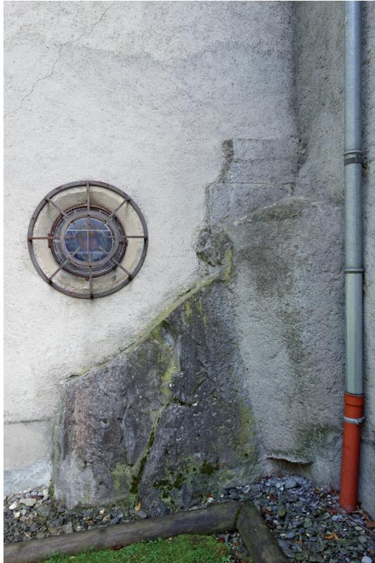
Fig. n° 49 : Contrefort en calcaire noir de Sixt implanté sur le rocher situé dans le mur nord de la nef médiévale
