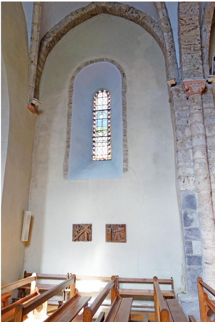
Fig. n° 61 : Angle nord-ouest de la nef médiévale, reprise en sous-cœuvre du pilier au moyen de calcaire noir de Sixt
