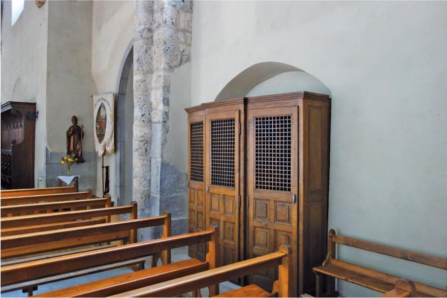
Fig. n° 62 : Angle sud-ouest de la nef médiévale, reprise en sous-œuvre du pilier au moyen de calcaire noir de Sixt et ancienne porte vers le cloître
