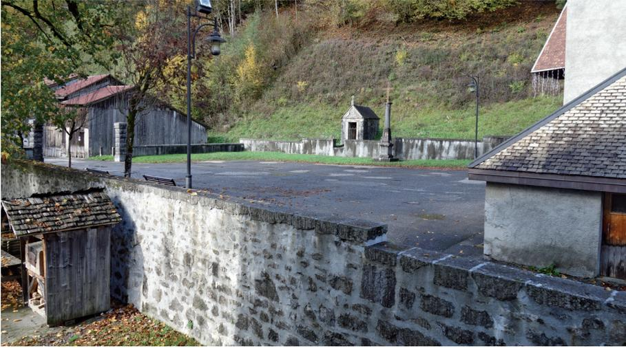
Fig. n° 76 : Mur de soutènement de la parcelle de l'église construit en 1877 à l'emplacement du cloître et de l'aile occidentale
